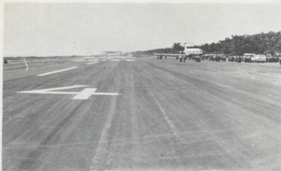
Aeropuerto de Limón, construido en tiempo record de 45 días. Totalmente terminado y puesto en servicio en la actualidad.
