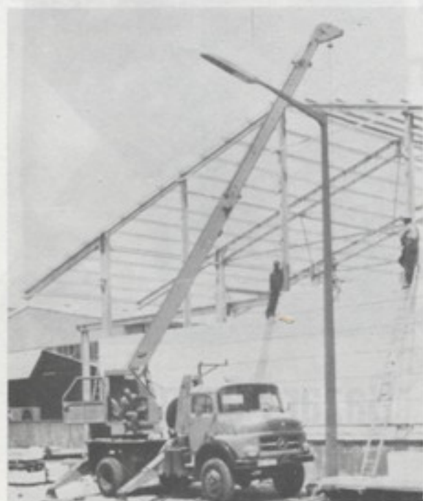
LA 1313 Superestructura con grúa.
