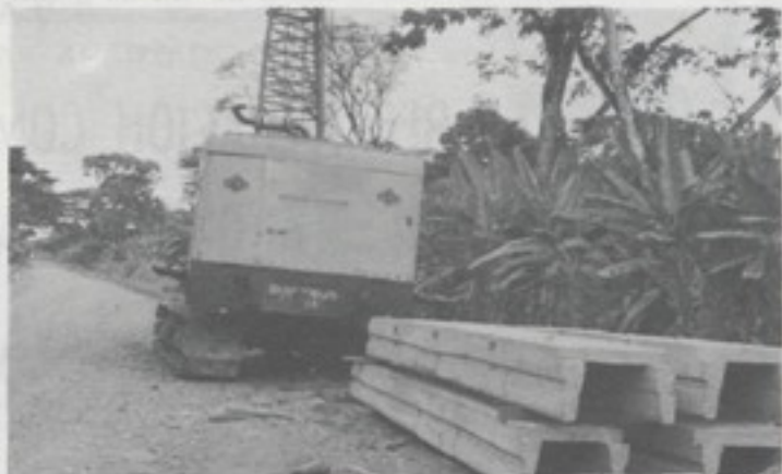
Canaletas de concreto pretensado listas para su colocación.
