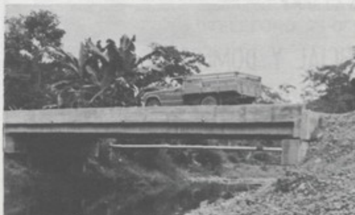
Puente rústico de canaletas pretensadas sobre la carretera a Limón, C. R.
