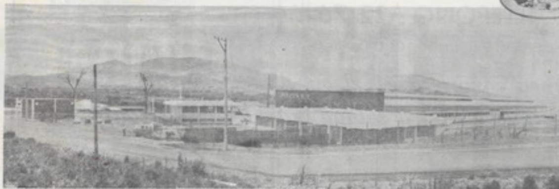
Vista de las instalaciones de Conducen
