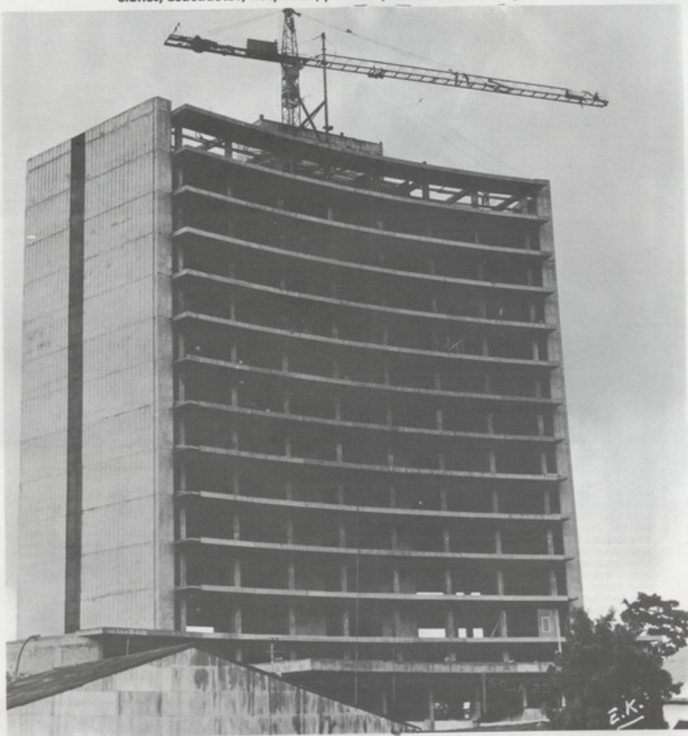
Vista de la construcción del edificio de oficinas centrales del ICE, que lleva a cabo EDICA LTDA, en Sabana Norte, San José.
