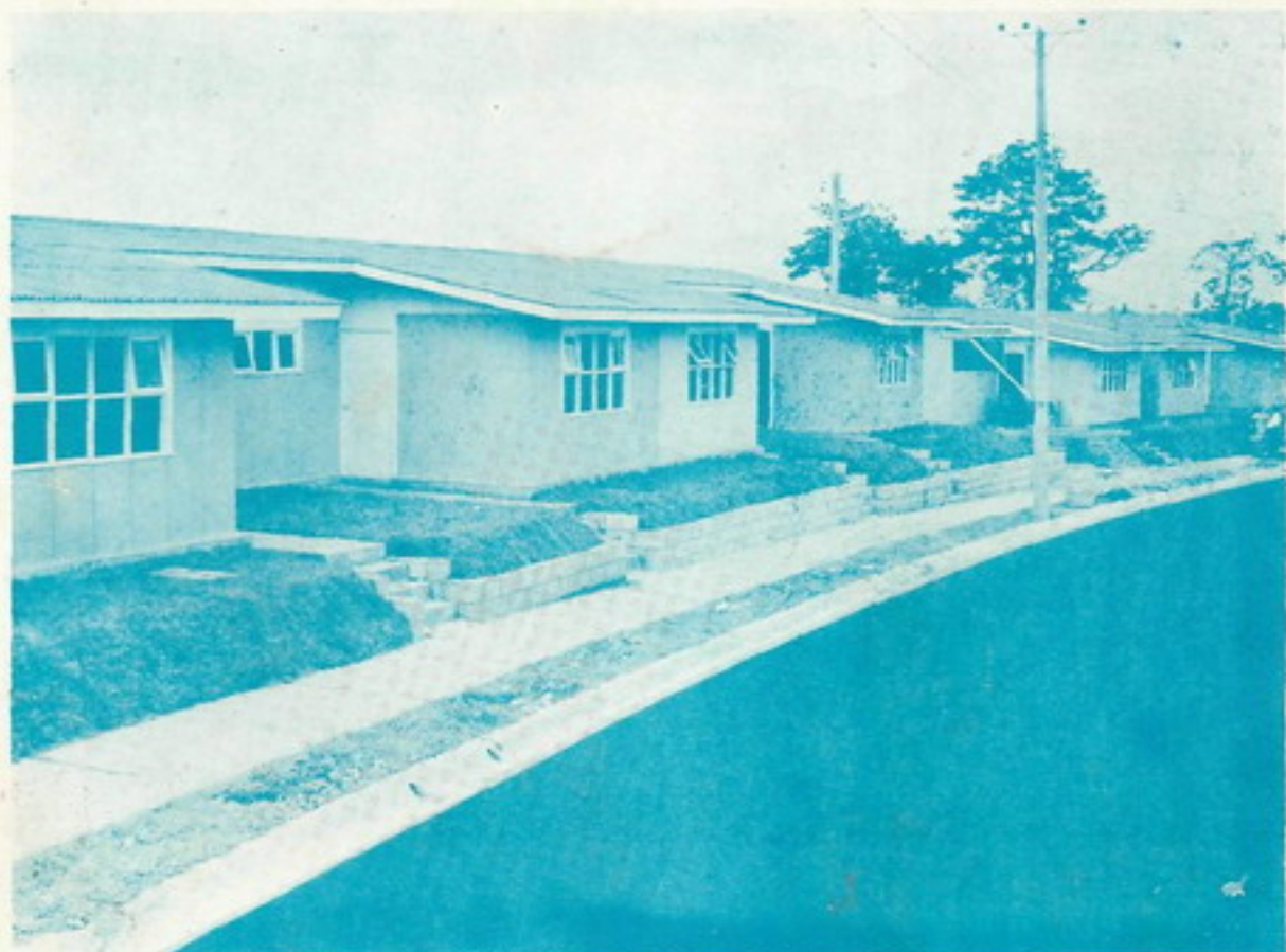
Vista parcial de la Urbanización El Porvenir, de Dusa S.A. Ubicada en Desamparados. Tal como se aprecia, todas las casas han sido techadas con SUPERFLEX.
