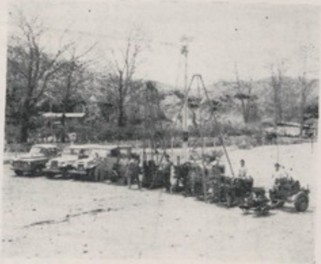
Vista parcial de nuestro equipo de maquinaria
