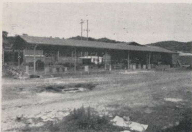
INSTALACIONES TECHADAS CON SUPERFLEX EN: PRODUCTOS DE CONCRETO S. A.
