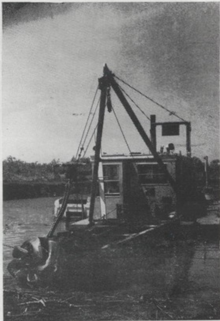
Draga flotante "Saakje" con la que se construyó el Canal
