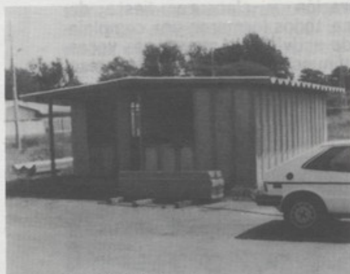
Vista principal de la vivienda.
