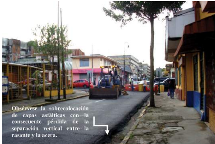
Figura N° 1. Sobrecapas de asfalto en vías urbanas de San José. Fuente: el autor.
