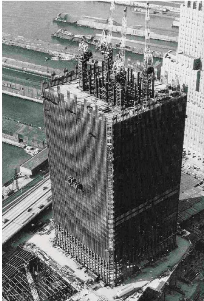
El diseño de las torres inició en 1960 y su construcción finalizó en 1973.
