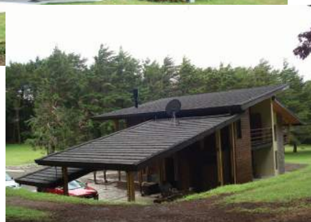
Cubierta teja DECRA shake SABLE CROACIA
