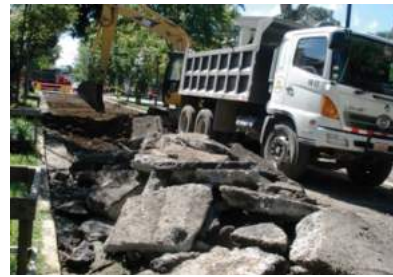
Figura N° 2. Proceso de demolición. Fuente: el autor.
