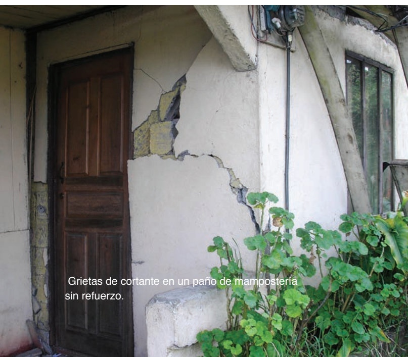
Esquina desintegrada. Nótese la ausencia de acero horizontal así como de la viga corona.
